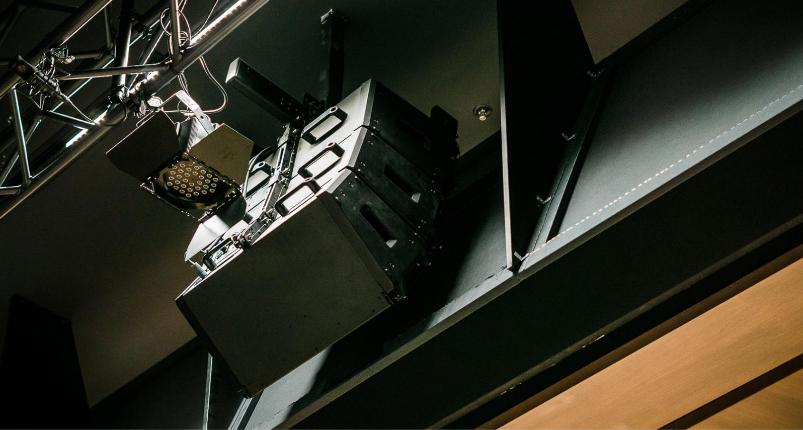
comprenant une enceinte ShowMatch SM5 DeltaQ, une enceinte ShowMatch SM10 DeltaQ et une enceinte ShowMatch SM20 DeltaQ avec des guides d'ondes correspondants parfaitement alignés. Le traitement de signal et l'alimentation des enceintes sont assurés par quatre amplificateurs PowerMatch : un PM4250, un PM4250 et deux PM8250.
